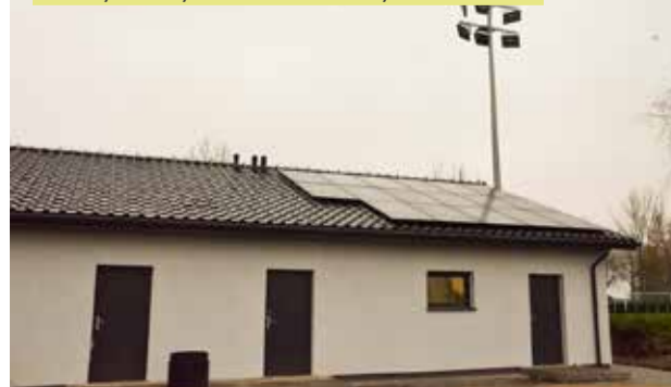
Nowy budynek szatni w Sycewicach
