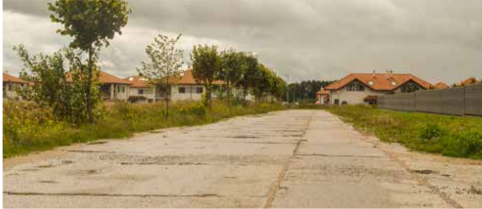
Stare płyty betonowe na ulicy Paderewskiego zastąpi kostka betonowa.
