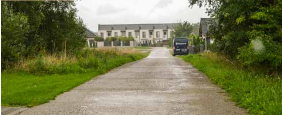
Na ulicy Migdałowej wybudowana zostanie nawierzchnia z kostki betonowej.
